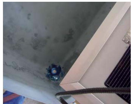
Abb. 38: Wasserabfluss mit Dichtmasse fixiert
